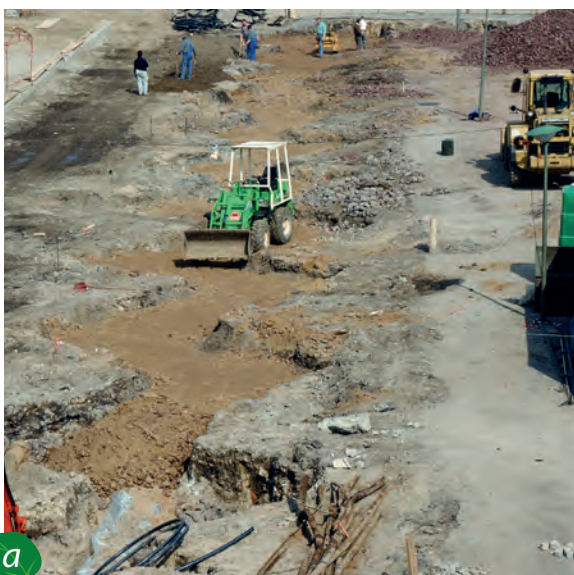
Abbildung 55: Vorläufer moderner Baum-Rigolen am Beispiel der Stadt Osnabrück: a) 40 Linden teilen sich auf einem Platz einen gemeinsamen Wurzelraum, der mit einer sehr grobkörnigen Skeletterde gefüllt ist. b) Solche Anlagen können nach Belieben bedeckt und anschließend belastet werden, ohne dass dem Wurzelraum der Bäume die Gefahr droht, zuvor überverdichtet zu werden.
