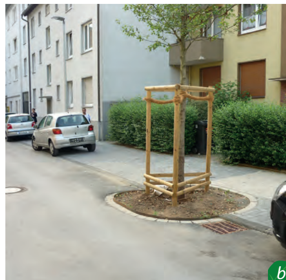
Abbildung 54: Regenwassereinleitung in Baumstandorte am Beispiel der Stadt Bochum: a) Nach dem Einsetzen des Baumes erfolgt der Anschluss einer Dränleitung an den innerhalb des Wurzelraumes stehenden Sinkkasten. b) Niederschläge vom Gehweg und der Straße gelangen über diesen Einlauf zum Baum. Eine Überlaufmöglichkeit in den Hauptkanal verhindert eine Überstauung des Standortes.
