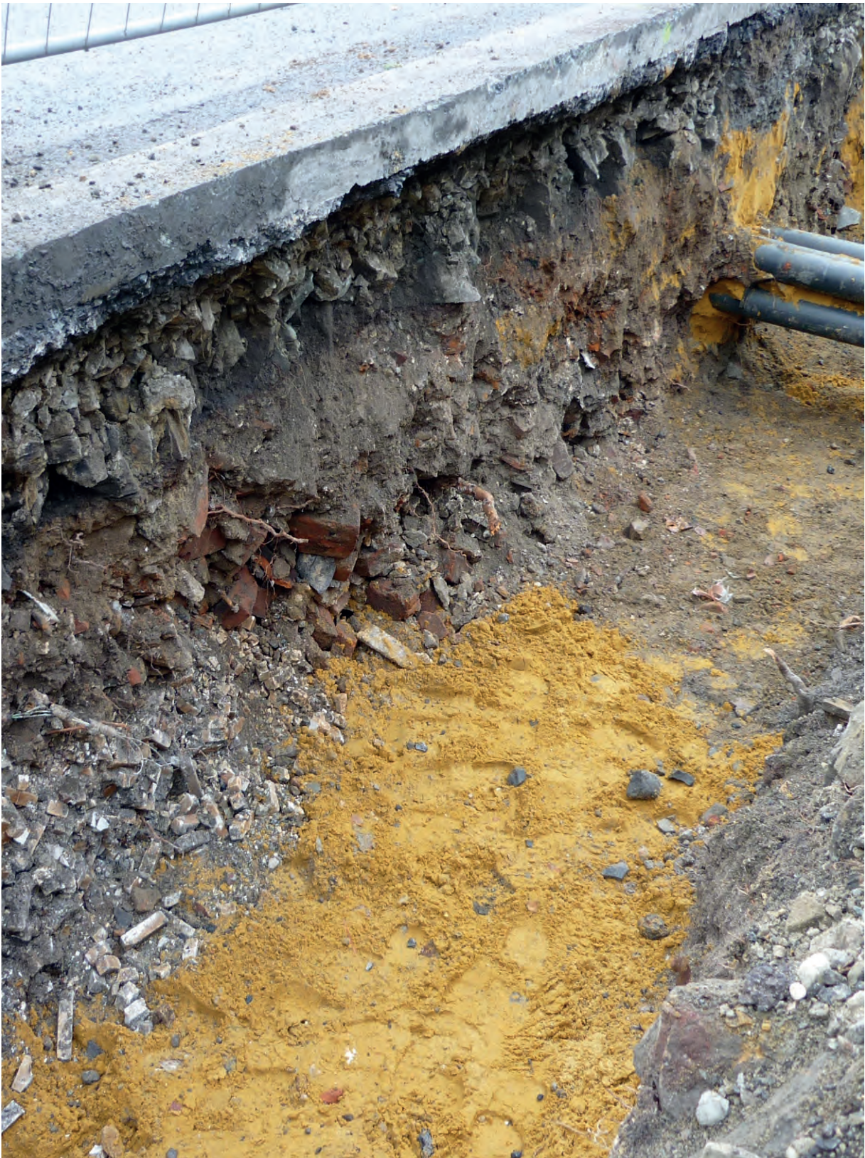
Abbildung 10: Der Blick in einen typischen Stadtboden zeigt dessen hohe Diversität. Auch solche Bereiche können den Wurzelraum eines Baumes bilden, wenn deren physikalische und chemische Eigenschaften den Bedürfnissen von Bäumen nicht grundsätzlich entgegenstehen.
