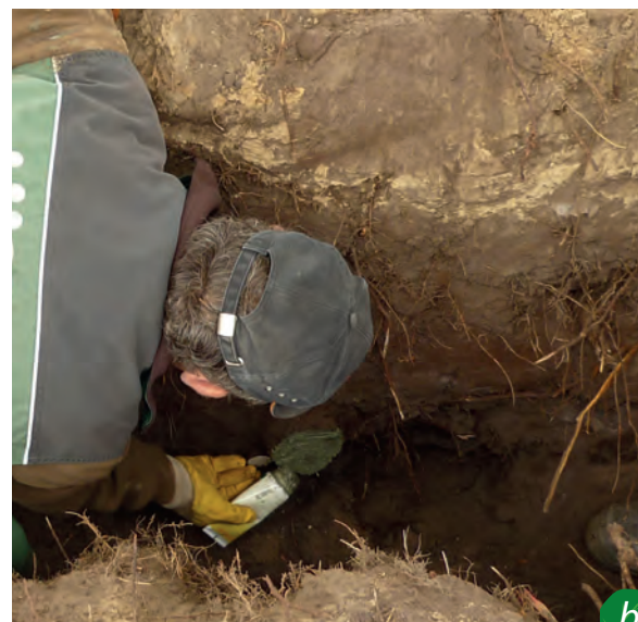
Abbildung 17: Praktischer Baumschutz auf Baustellen in der Stadt Hamburg: a) Bei Erdarbeiten werden statisch relevante Wurzeln nicht durchtrennt, sondern wurzelschonend in Handschachtung freigelegt und bis zur Verfüllung des Grabens vor Austrocknung geschützt. b) Bei unabdingbaren Entnahmen von Wurzeln erfolgt umgehend die fachgerechte Nachversorgung der Wunden, so dass sich an ihnen rasch neue Wurzeln bilden können.
