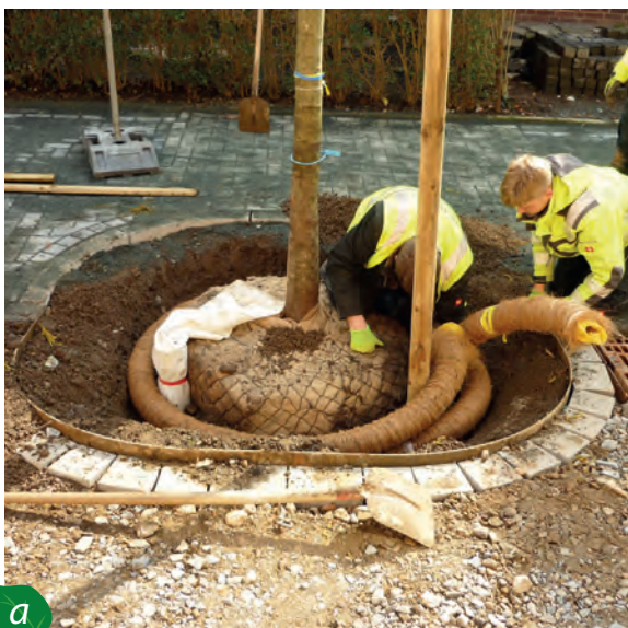
Abbildung 54: Regenwassereinleitung in Baumstandorte am Beispiel der Stadt Bochum: a) Nach dem Einsetzen des Baumes erfolgt der Anschluss einer Dränleitung an den innerhalb des Wurzelraumes stehenden Sinkkasten. b) Niederschläge vom Gehweg und der Straße gelangen über diesen Einlauf zum Baum. Eine Überlaufmöglichkeit in den Hauptkanal verhindert eine Überstauung des Standortes.
