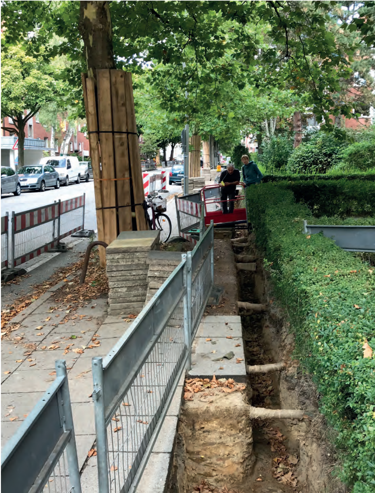
Abbildung 15: Der Erhalt von statisch (und zur Baumversorgung) notwendigen Wurzeln bei Baumaßnahmen stellt zumeist kein Problem dar und kann leicht berücksichtigt werden, wenn dies rechtzeitig vor dem Beginn eines Bauvorhabens allen Beteiligten gegenüber thematisiert und die Maßnahme baumfachlich begleitet wird.
